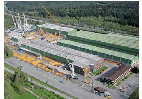
Firma Liebherr, Nenzing
