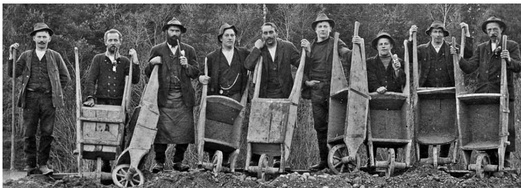
Hochwasserschutzmaßnahmen Nenzing ca. 1925. (Foto: Gemeindeforschung Nenzing)
