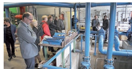
Die Regio-Bürgermeister haben den Zustand des Walgaubades mehrfach genau inspiziert.
