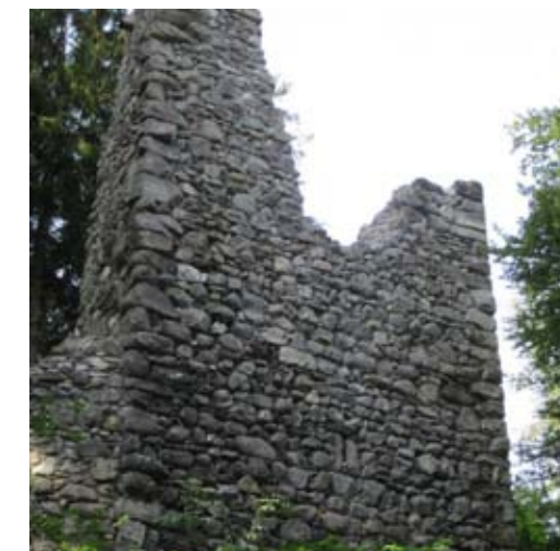
Restaurierte Bergfriedmauer von Schwarzenhorn
